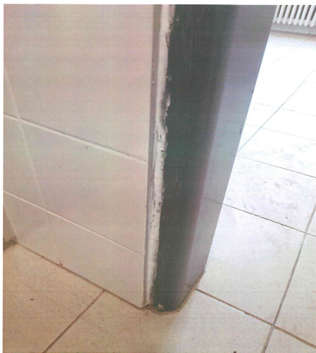
Nekvalitné a neodborné tmelenie škár, styku dvernej zárubne a keramického obkladu
