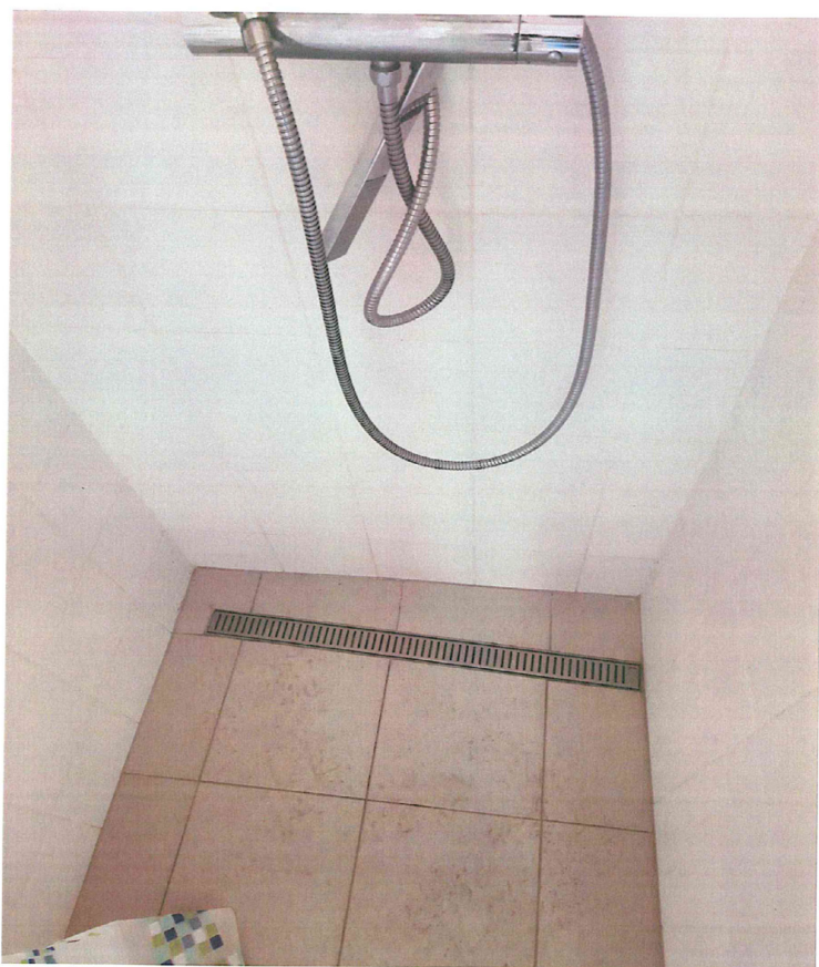
Krivé osadenie odtokových kanálikov v sprchách
