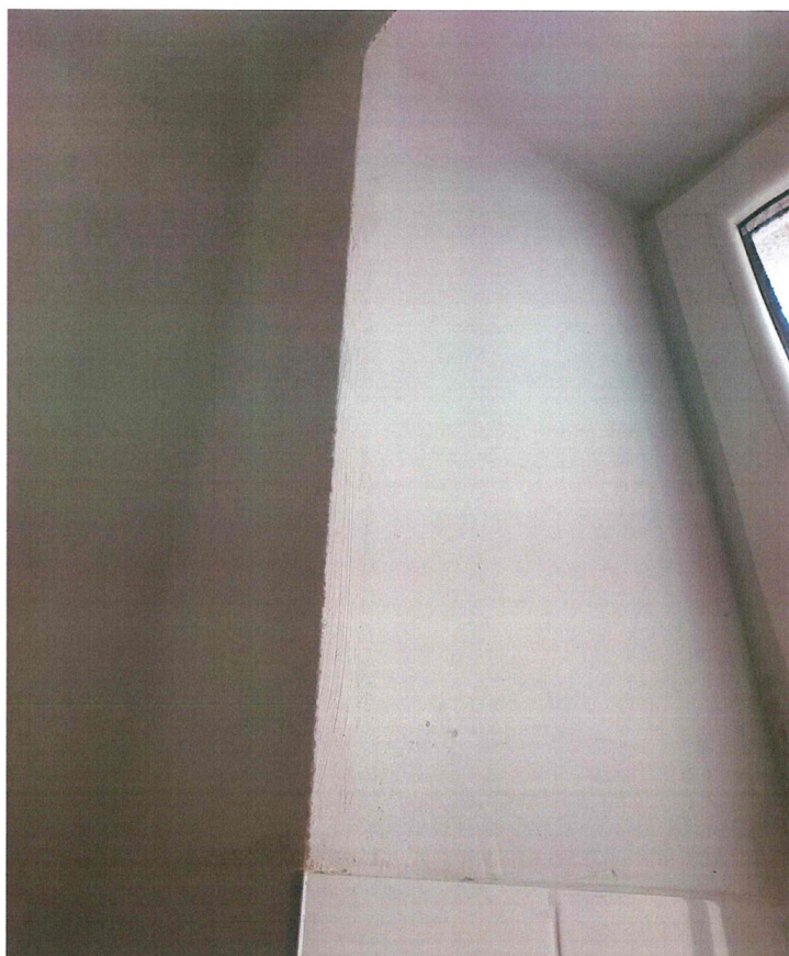
Nerovnosti a nízka vizuálna kvalita prevedenia rohov v miestnostiach sociálnych zariadení
