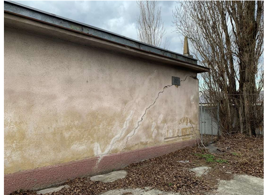
Pohľad na statickú poruchu na objekte – zadná časť objektu
